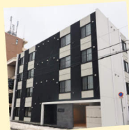
輝和サウス (KIWA) 中央区南7条西12丁目 地下鉄東西線 「西11丁目」 徒歩10分
