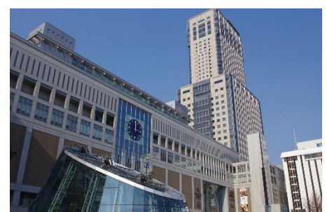
再開発が進む札幌駅南口
